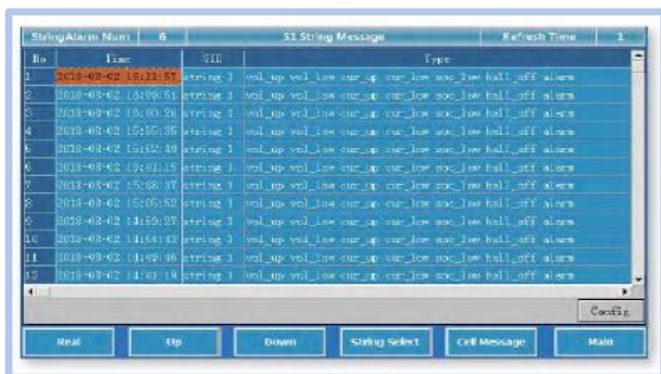
Ereignis-Anzeige und Alarm-Abfrage
